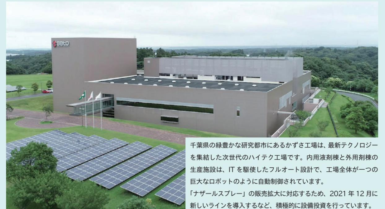
千葉県の緑豊かな研究都市にあるかずさ工場は、最新テクノロジーを集結した次世代のハイテク工場です。内用液剤棟と外用剤棟の生産施設は、ITを駆使したフルオート設計で、工場全体が一つの巨大なロボットのように自動制御されています。「ナザールスプレー」の販売拡大に対応するため、2021年12月に新しいラインを導入するなど、積極的に設備投資を行っています。
